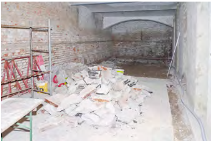
Aus einem baufälligen Keller wurde im Jahr 2010...
